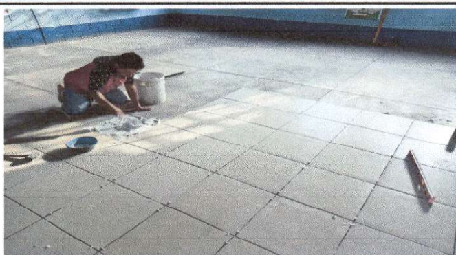
Foto 1: Cambio de psio de cemento por piso cerámico
