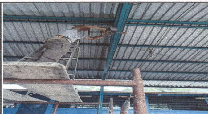
Foto 3: Se colocará un cableado eléctrico para la iluminación del centro educativo.
