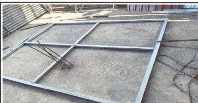
Foto 6: Cambio de portón por estar en mal estado.
