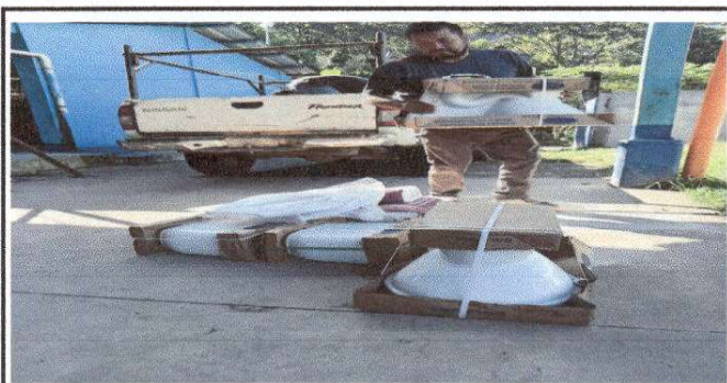
Foto 5: Cambio de hinodoro
