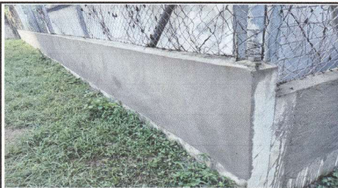
Foto 2: Repello y pintura de pared perimetral
